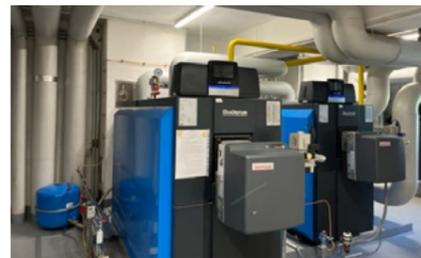
Neue, erdgasbetriebene Brennwertkessel im LLG Halle
